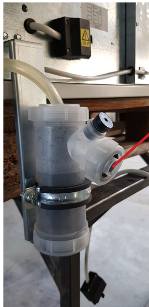
5. ábra: Kondenzvíz elvezető szifon felszerelése
