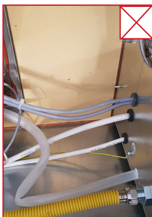
HELYTELEN belső szilikon cső hossz
