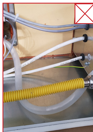
HELYTELEN belső szilikon cső hossz
